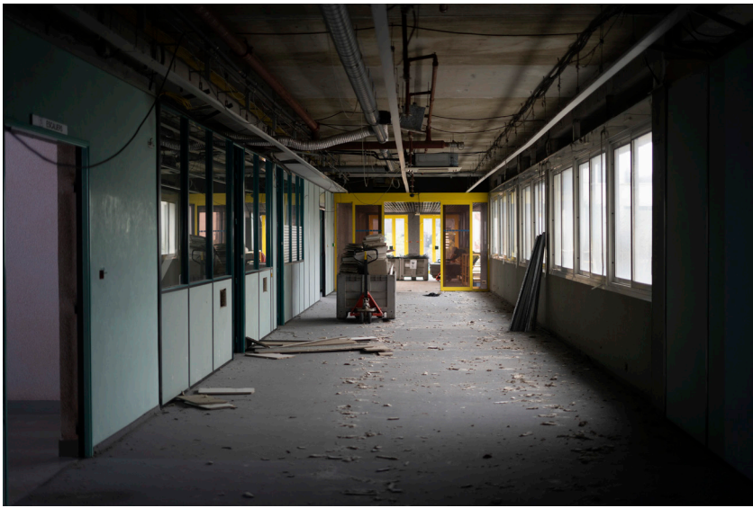
Chantier d'Airbus © Victor Charrier
