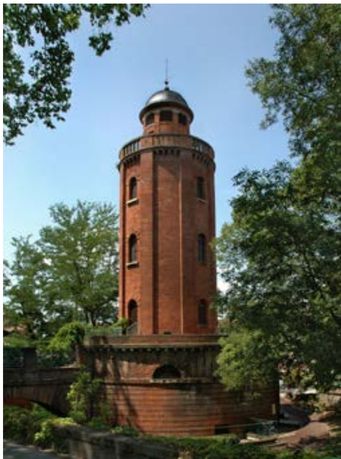
Le Château d'Eau © Le Nouveau Printemps
